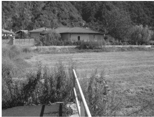
Stralcio 1, Int. C71bis Veduta dal vertice Nord-occidentale, dall'esistente traversa di via Roma
