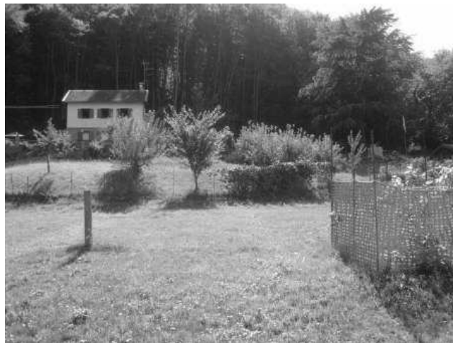
Stralcio 2, Int. C108 Veduta da Nord (lato valle)
